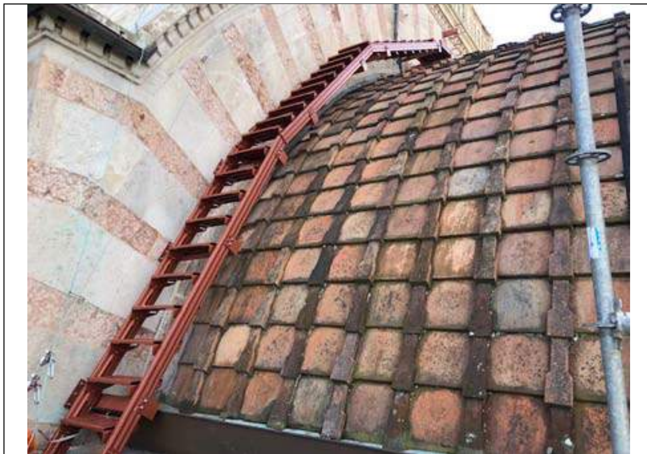
SCHEDA ALLEGATA N21A – Realizzazione di accesso in sicurezza esterno alla cupola interna del Tempio ebraico
