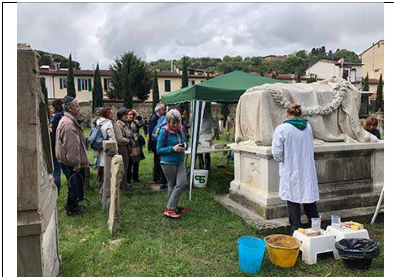
SCHEDA ALLEGATA N.23A – Cantiere “IL RESTAURO IN DIRETTA” la Scuola dell’Istituto Palazzo Spinelli nell’antico cimitero ebraico di Firenze
