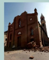
DUOMO DI MIRANDOLA (MO) Danneggiato dal sisma il 20 Maggio 2012.
